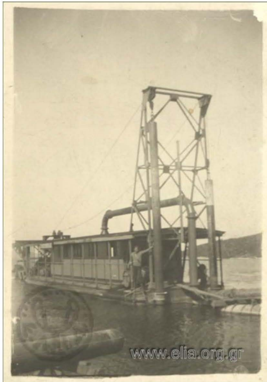
Φωτογραφίες 17-18, Εικόνες εξωφύλλου. Αποξηραντικά έργα στο έλος Λεσίνι, η αναρροφητική βυθοκόρος Επαμεινώνδας επί τω έργω. Πηγή: Αρχείο ΕΛΙΑ 1934-1940.
