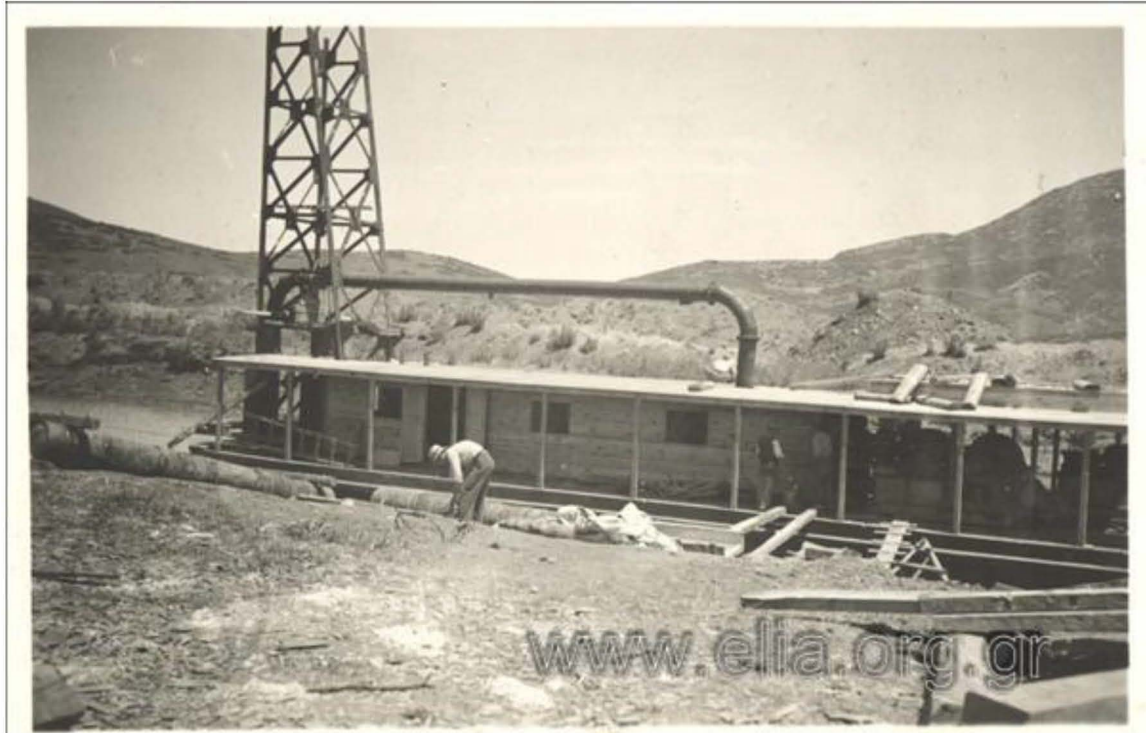
Φωτογραφία 22. Αποξηραντικά έργα στη λίμνη Ξονιάδα: συναρμολόγηση και τοποθέτηση των μηχανισμών της βυθοκόρου "Ξονιάς", σχεδιασμένης από τον Μιχαήλ Σουκώκη. Πηγή: Αρχείο ΕΛΙΑ 1938-1940.
