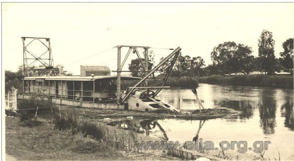
Φωτογραφία 10. 326 Αποξηραντικά έργα στο έλος Λεσίνι η βυθοκόρος Επαμεινώνδας, σχεδιασμένη από τον Μιχαήλ Συκώκη, επί τω έργω. Πηγή: Αρχείο Ε.Π.Α 1934-1940.
