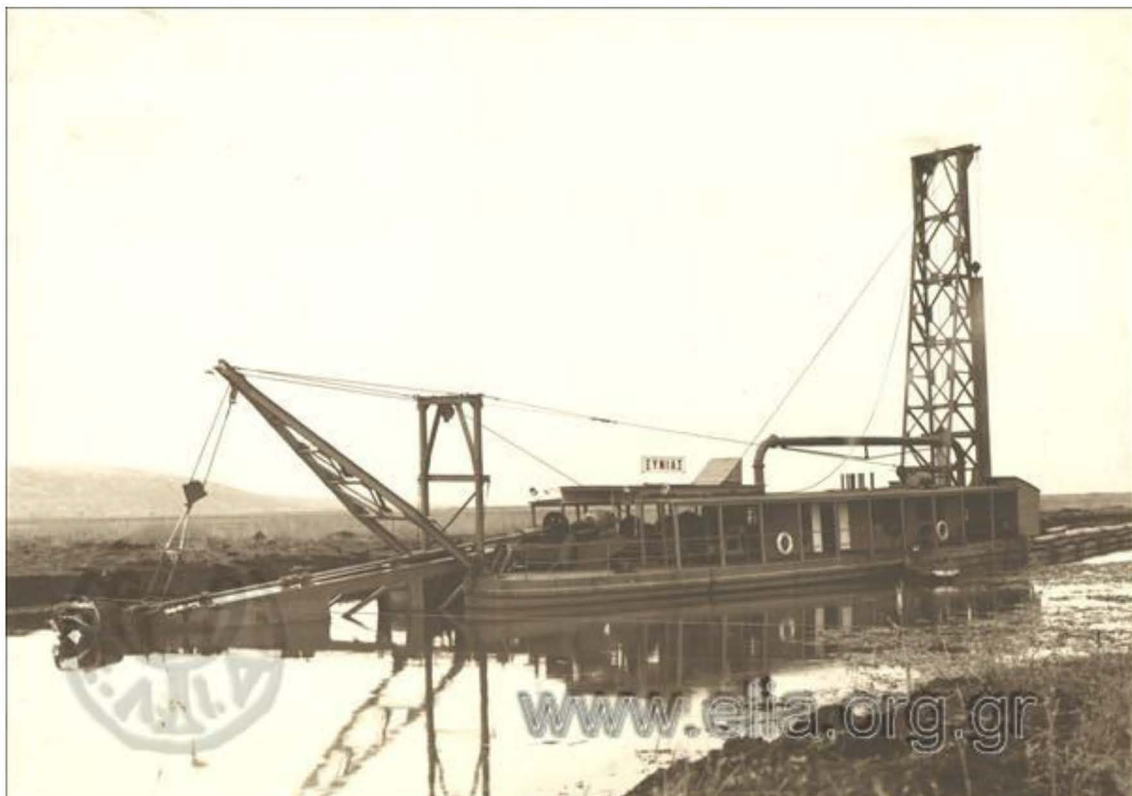
Φωτογραφία 23. Αποξηραντικά έργα στη λίμνη Ξονιάδα (Φθιώτιδα): η βυθοκόρος "Ξονιάς" κατά τη διάρκεια εκσκαφής της κόριας αποχετευτικής διάβρυγας. Πηγή: Αρχείο ΕΛΙΑ 1938-1940.
