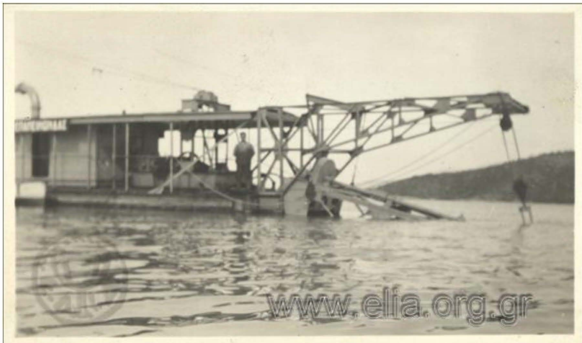
Φωτογραφία 19. Αποξηραντικά έργα στο έλος Λεσίνι, η αναρροφητική βυθοκόρος Επαμεινώνδας επί τω έργω. Πηγή: Αρχείο ΕΛΙΑ 1934-1940.
