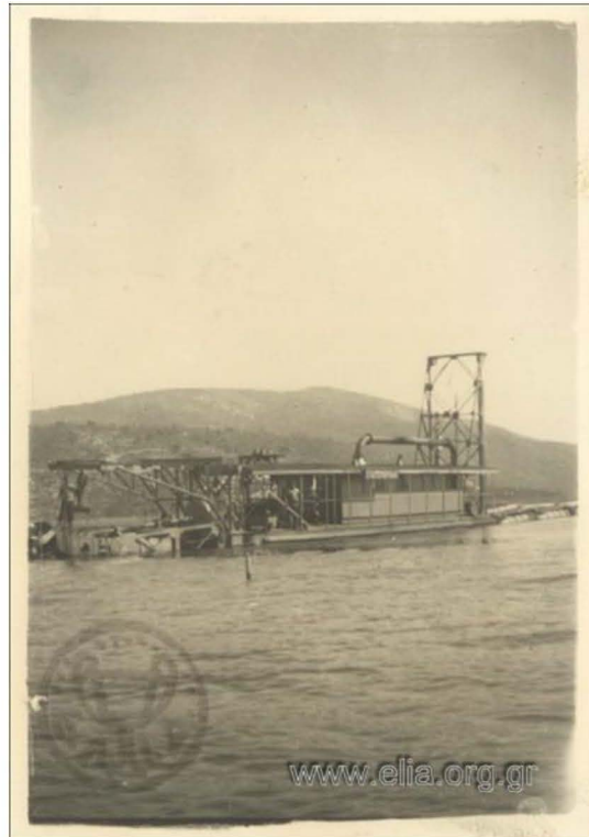
Φωτογραφίες 17-18, Εικόνες εξωφύλλου. Αποξηραντικά έργα στο έλος Λεσίνι, η αναρροφητική βυθοκόρος Επαμεινώνδας επί τω έργω. Πηγή: Αρχείο ΕΛΙΑ 1934-1940.
