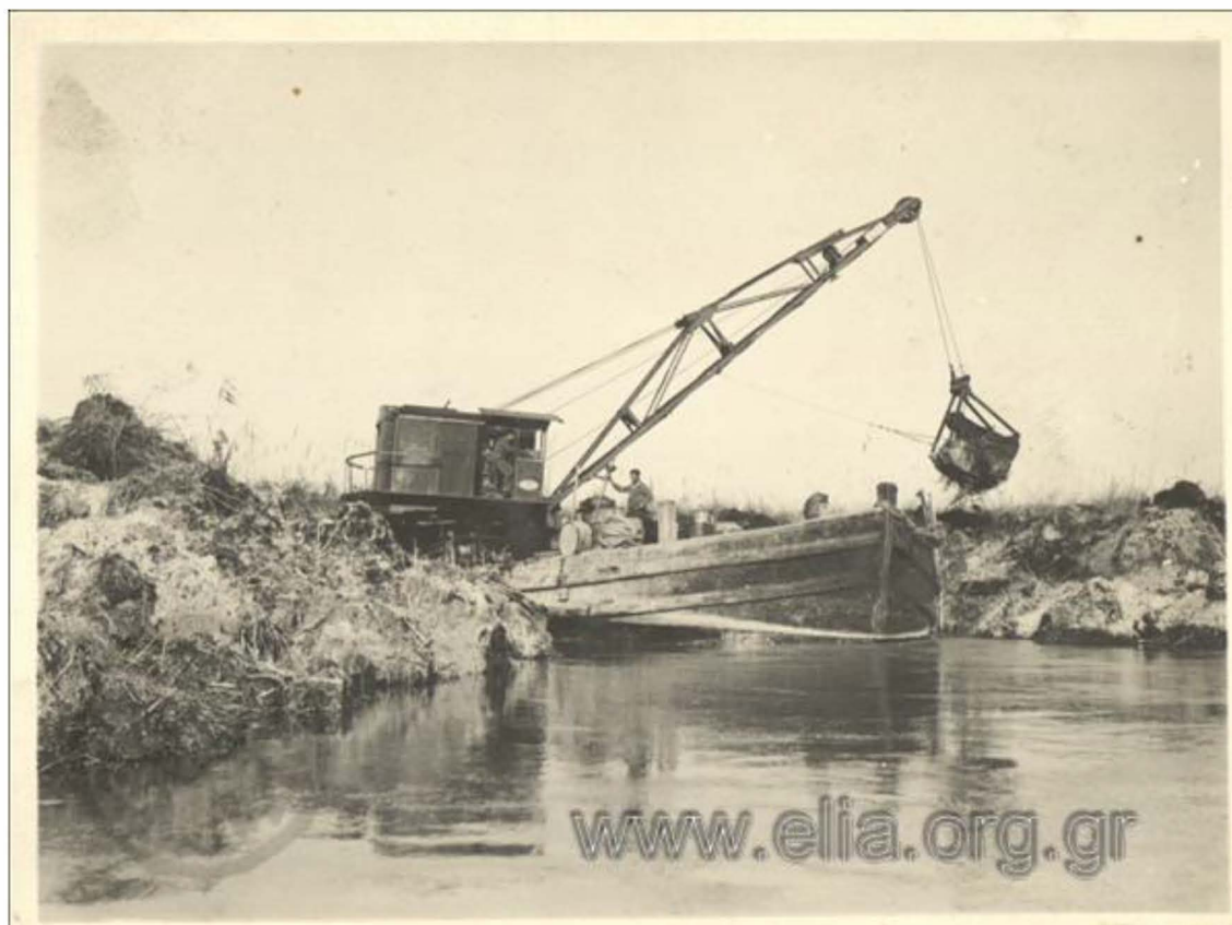
Φωτογραφία 5. Αποξηραντικά έργα στο έλος Λεσίνι, πρώτη μέθοδος εκσκαφής με φαγάνα. Πηγή: Αρχείο ΕΛΙΑ 1934-1940.
