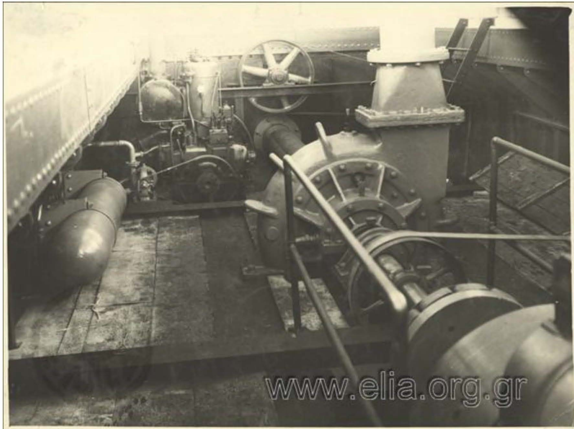
Φωτογραφία 20. Αποξηραντικά έργα στο έλος Λεσίνι: η αντλία αναρροφήσεως και εκπομπής βυθοκορημάτων στο κατάστρωμα της βυθοκόρου "Επαμεινώνδας" (σχεδιασμένη από τον Μιχαήλ Συκόκη). Πηγή: Αρχείο ΕΛΙΑ 1934-1940.
