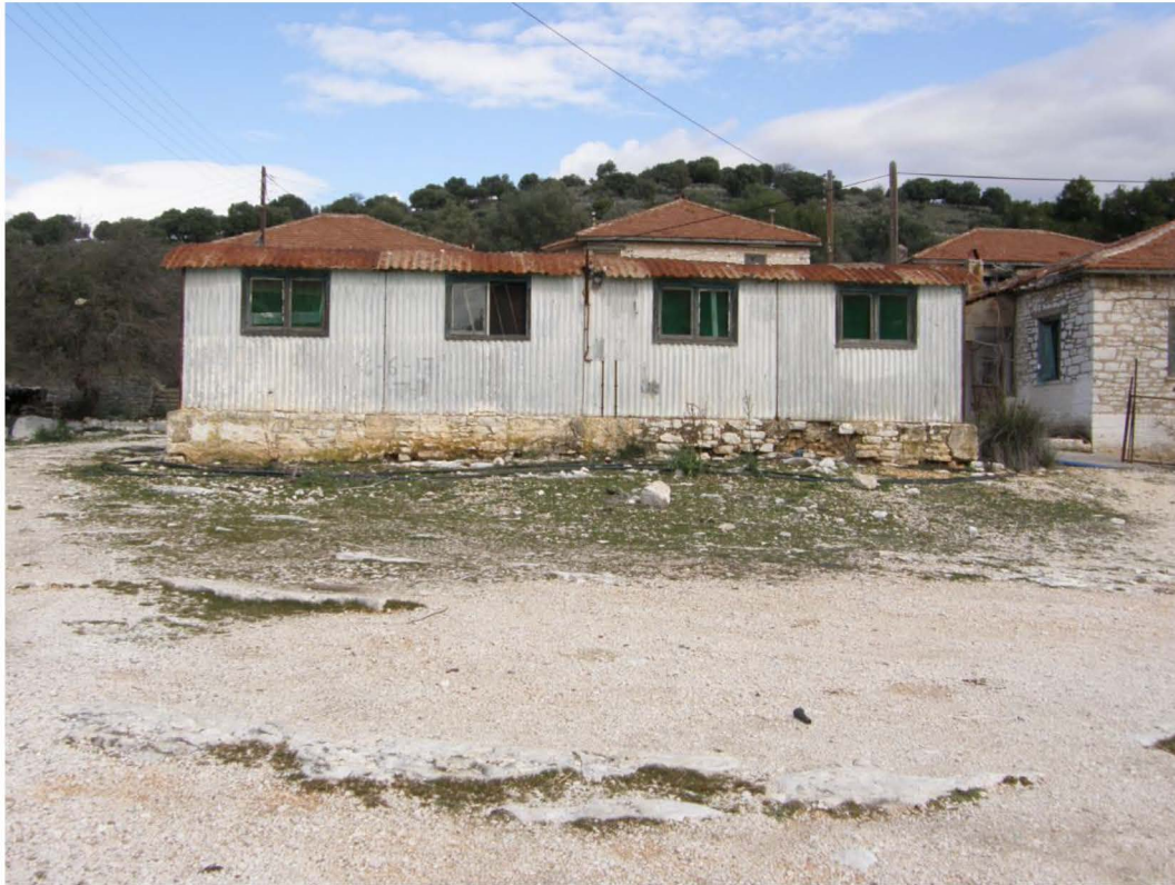
Φωτογραφία 15. Κτίριο στον οικισμό Βαλτί, στο οποίο πιθανόν να στεγάζονταν τα γραφεία της Γ.Ε.Α (2012, Χουλιάρας Σ.)
