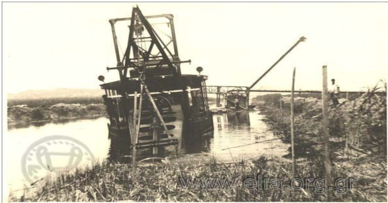
Φωτογραφία 9. 322 Αποξηραντικά έργα στο έλος Λεσίνι η βυθοκόρος Επαμεινώνδας, σχεδιασμένη από τον Μιχαήλ Συκόκη, ενσκάπτει την κύρια συλλεκτήριο τάφρο προς το αντλιοστάσιο. Πηγή: Αρχείο ΕΛΙΑ 1934-1940.
